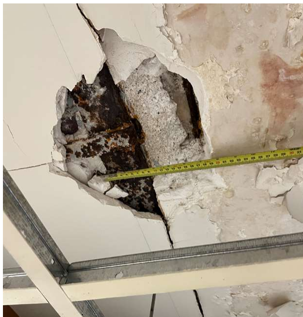
Fot. 6 Odkrywka nadproża
