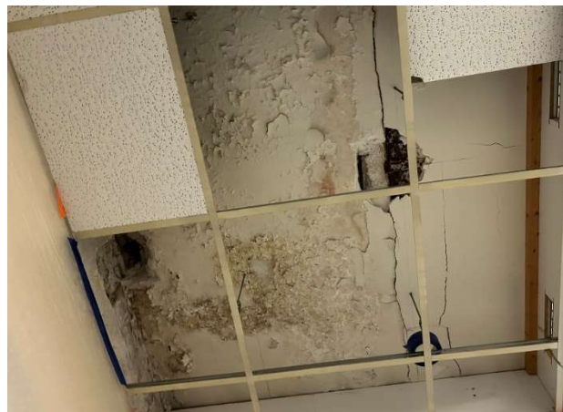
Fot. 5 Odkrywki stropu poziomu 0 stropu dziedzińca
