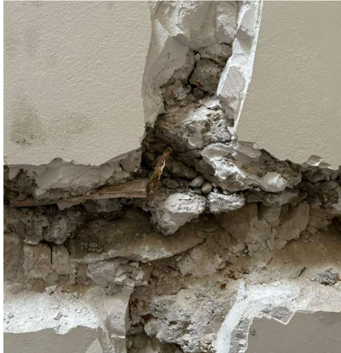
Fot. 3 Odkrywka w ścianie klatki schodowej oficyny – poziom +2
